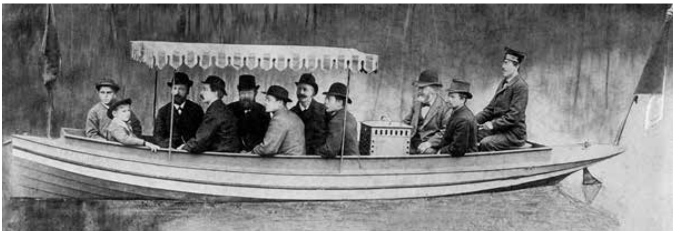
Pierwsza łódź motorowa Daimlera i Maybacha z silnikiem o mocy 2 KM podczas rejsu w 1886; przed sternikiem widoczni Daimler i Maybach; na dziobie ich synowie (od lewej) Paul Daimler i Karl Maybach; pod daszkiem przeciwsłonecznym robotnicy, którzy zbudowali łódź (fot. Daimler-Motoren-Gesellschaft)
